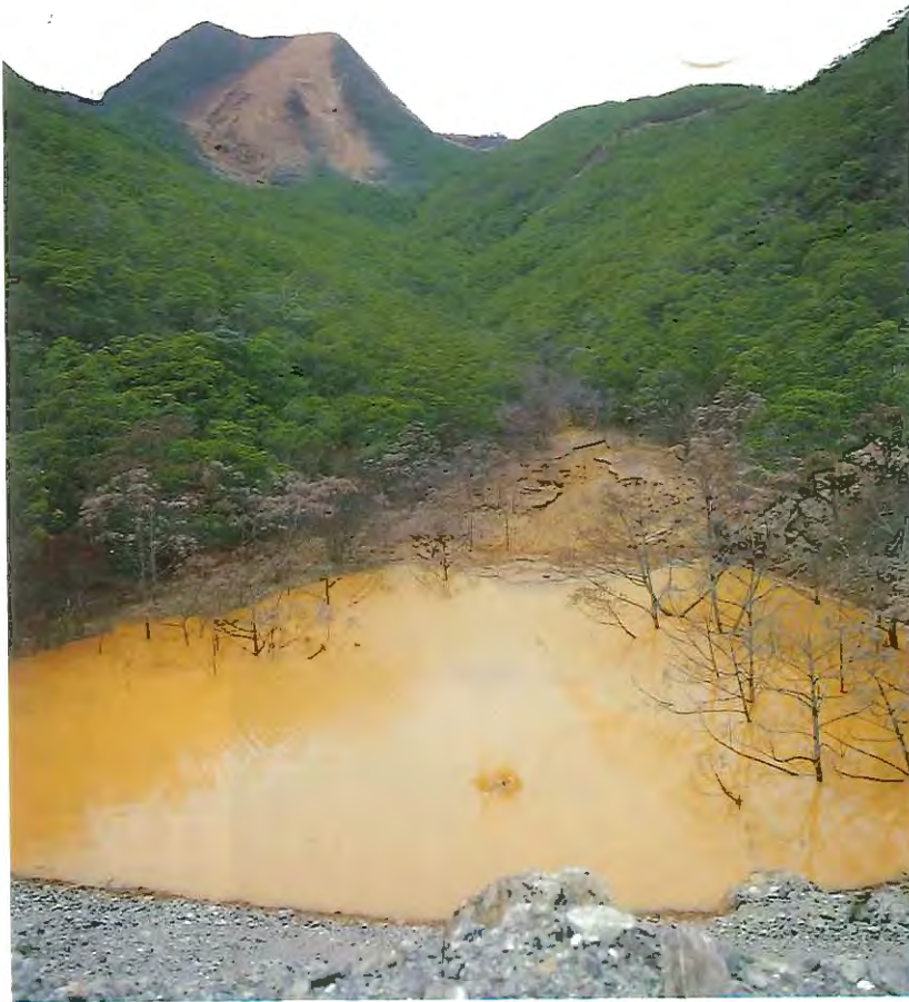
Figure 3 : Ouvrage de décantation des eaux collectées.
